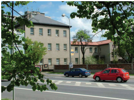
Hlavní budova školy
